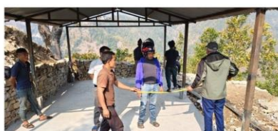
खपाङ्गी डाँडा घाटेपाटी तथा सतल निर्माण सम्पन्न पश्चात प्राविधिकबाट नापजाँच गरिदेको अवस्था ।
